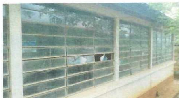
Foto 2: SUSTITUCIÓN DE VIDRIOS POR BALCONES
