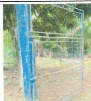
Foto 5: SUSTITUCIÓN DE PORTONES POR OXIDACIÓN
